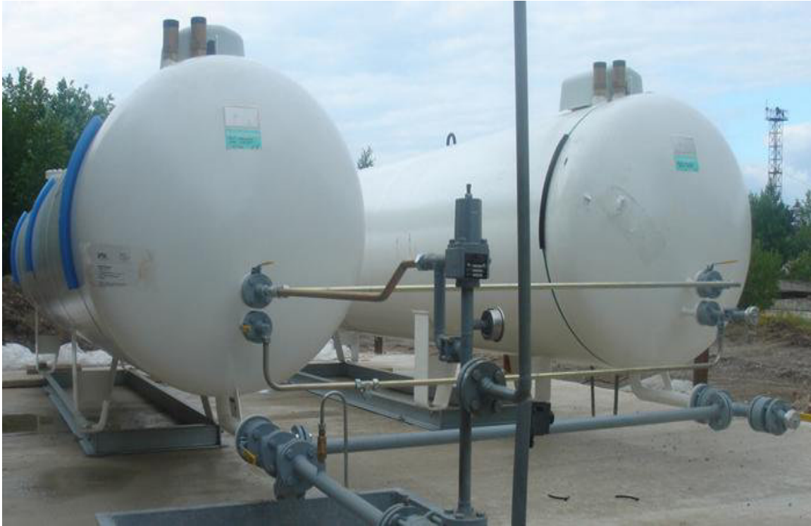
Рис. 4.11. Наземное газовое хранилище (газгольдер)
