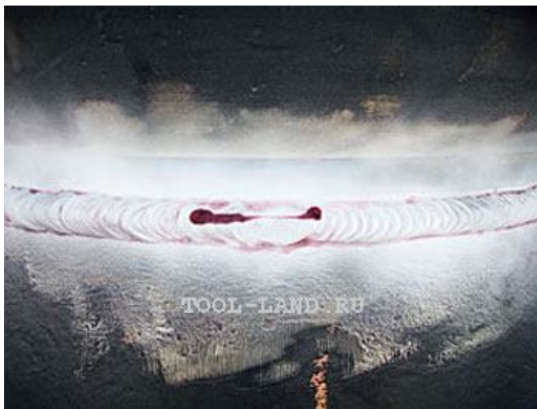
Рис. 8.15. Дефекты сварных соединений
