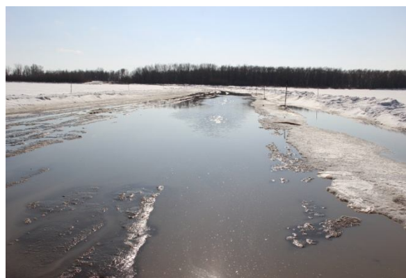
Рис.12. Распределение песка и последующее интенсивное таяние льда
