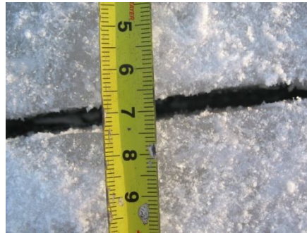
Рис. 5. Трещина в неармированной ледяной плите
