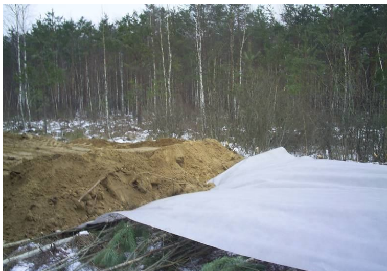
Рис. 5. Участок дороги с использованием геосинтетики и хворостяной выстилки
