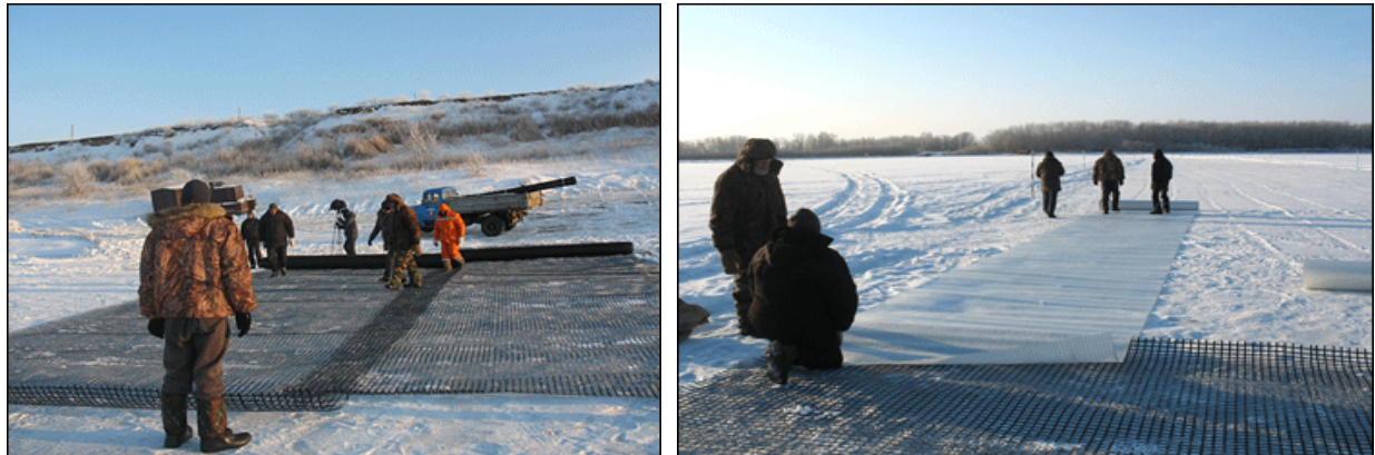
Рис. 8. Укладка георешётки (на стыке ледовой плиты с берегом) и геосетки
