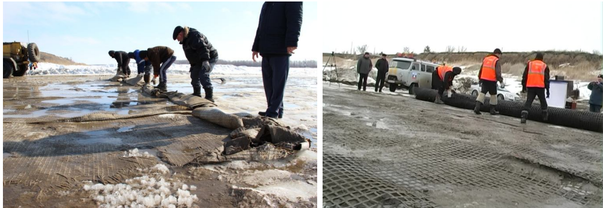
Рис.13. Удаление геосинтетических материалов
