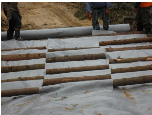
Рис. 6. Участок дороги с покрытием из тонкомерной древесины переплетенной геосинтетическим материалом
