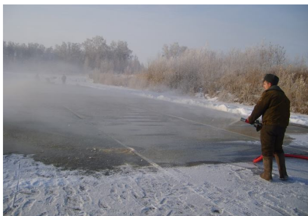
Рис.1. Укладка геокомпозита и поливка участка водой для намораживания льда («верхнее» армирование)
