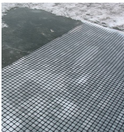
Рис.1. Укладка геокомпозита и поливка участка водой для намораживания льда («верхнее» армирование)
