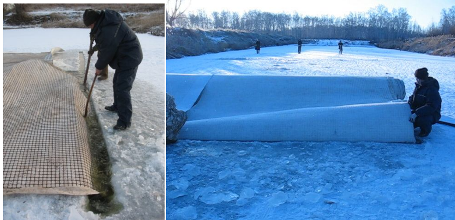
Рис. 3. Погружение геокompозита в «майну» и протаскивание его подо льдом капроновыми тросами («нижнее» армирование)
