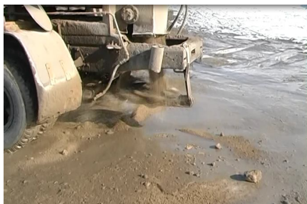
Рис.12. Распределение песка и последующее интенсивное таяние льда
