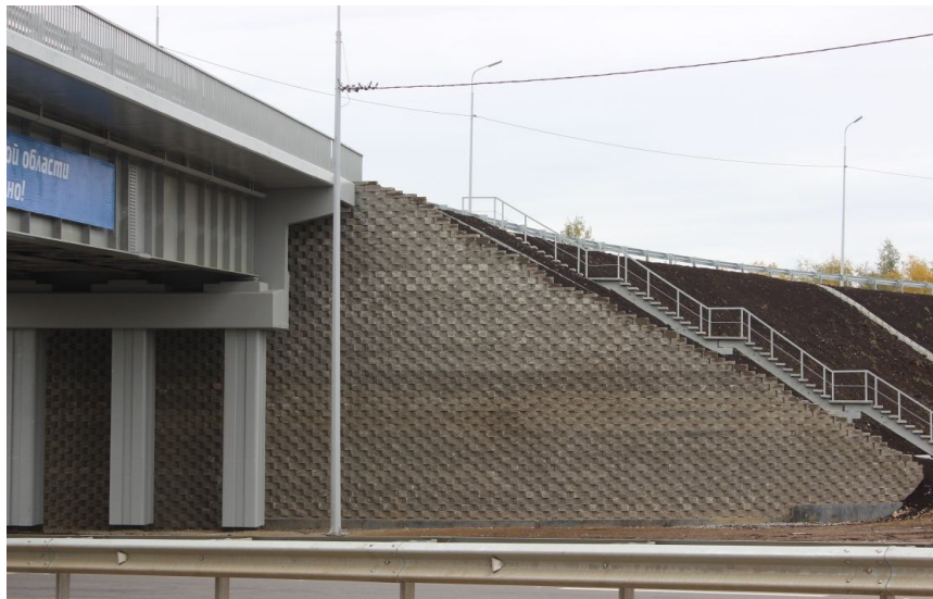
Рис. 6. Возведение двух транспортных развязок на автомобильной дороге Иркутск – Листвянка
