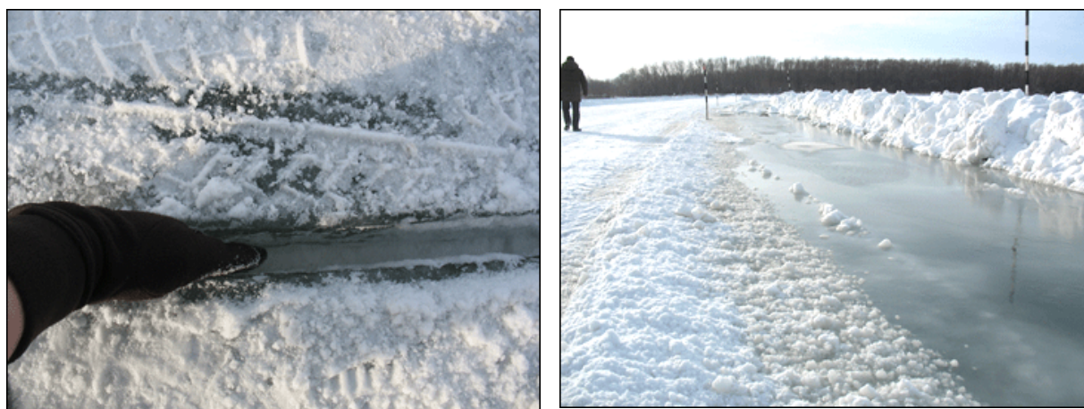
Рис. 11. Характерные проблемы на неармированной части ледового покрова
