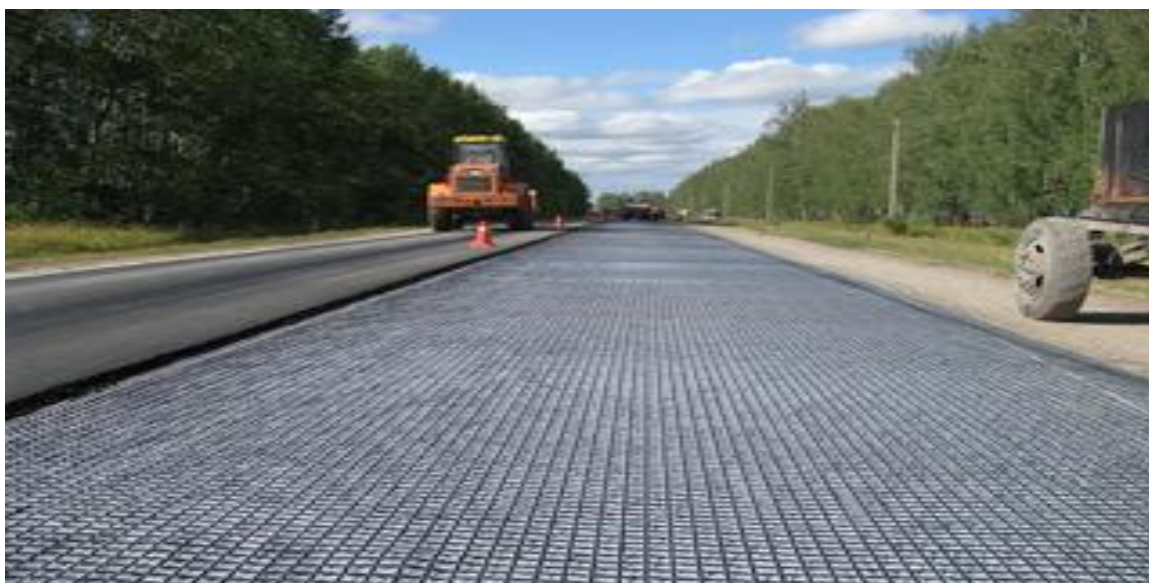
Рисунок 2 – Использование геосетки в конструктивных слоях дородной одежды
