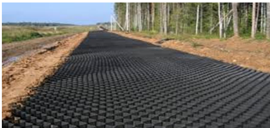
Рисунок 1 – Использование георешетки в конструктивных слоях дорожной одежды
