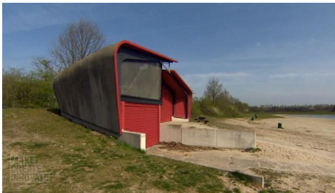
Рисунок 4 – Спасательная станция с использованием самовосстанавливающегося бетона
