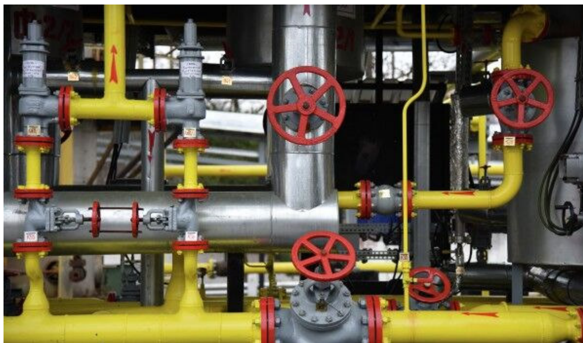
Рисунок 1 – Запорная арматура
