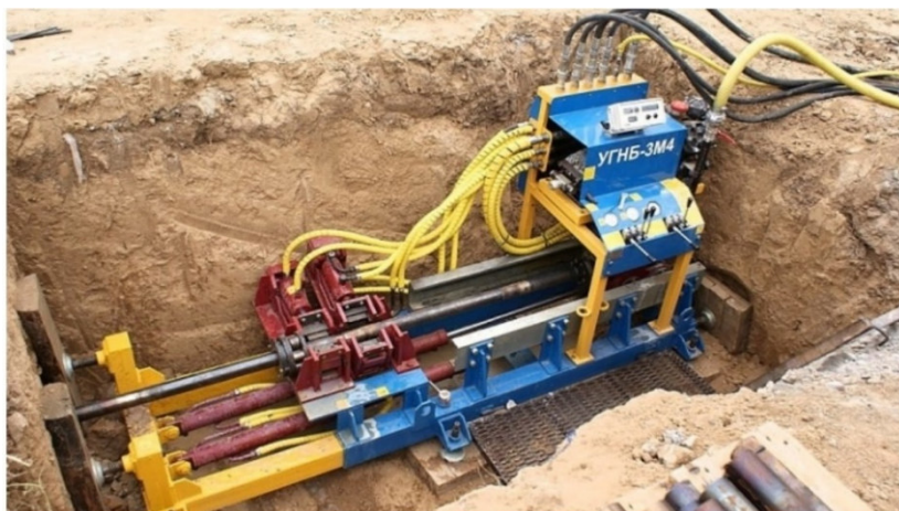
Рисунок 4 – Установка ГНБ в котловане
