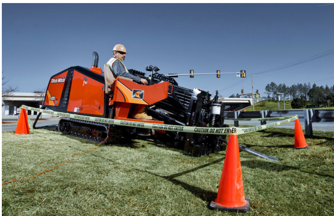
Рисунок 8 – Установка ГНБ JT25
