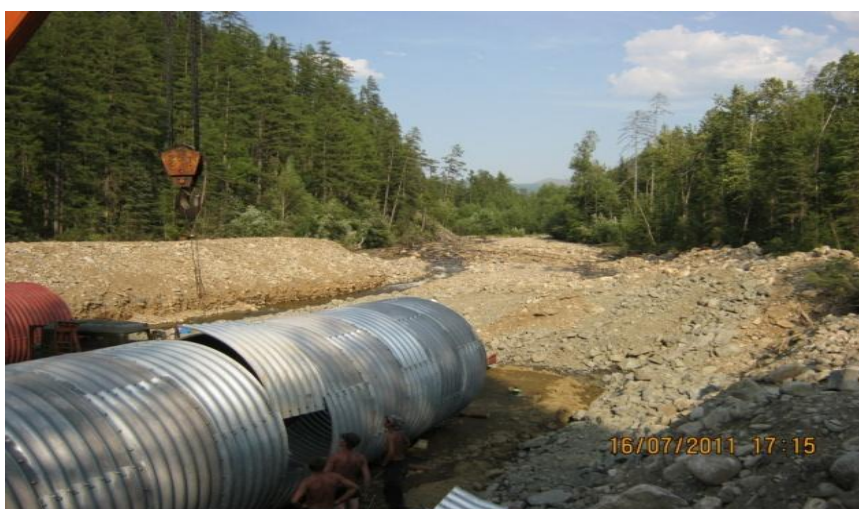
Рис. 3. Фрагмент сборки трубы
