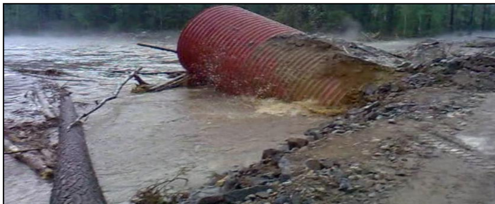
Рис. 2. Участок автомобильной дороги
