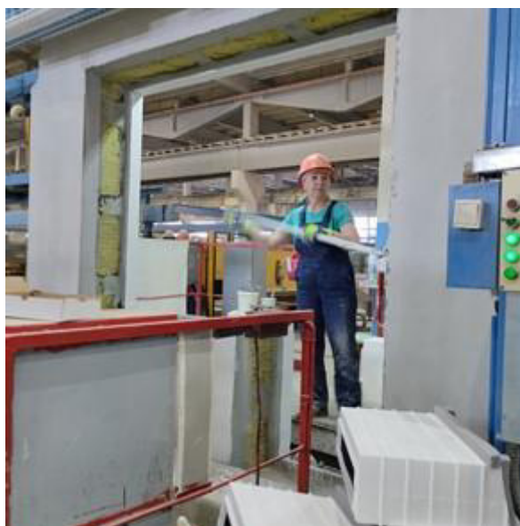
Рисунок 12 – Пост установки вентиляционного клапана, грунтовки
