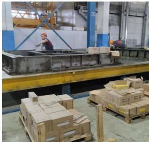
Рисунок 6 – Пост укладки матриц и плитки
