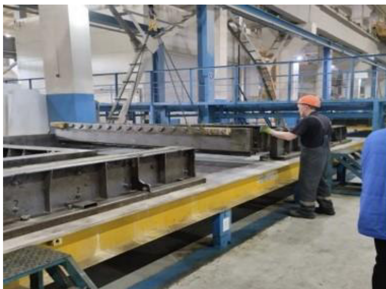
Рисунок 4 – Пост установки опалубки
