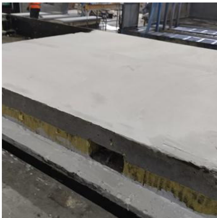
Рисунок 9 – Пост бетонирования второго слоя
