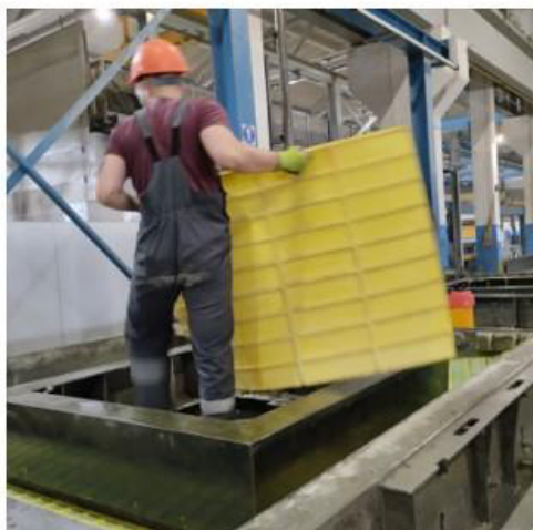
Рисунок 5 – Пост укладки матриц и плитки
