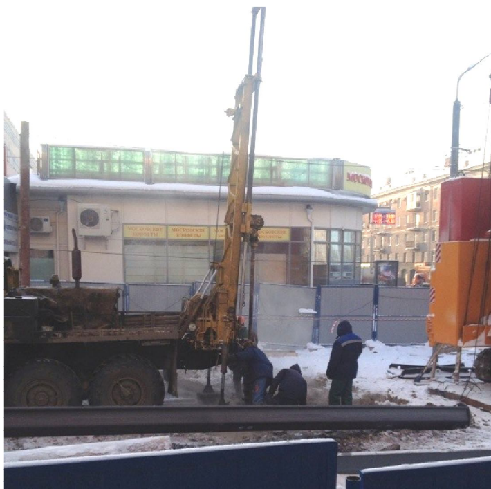
Рис. 6. Разбуривание контурной траншеи в мерзлом грунте
