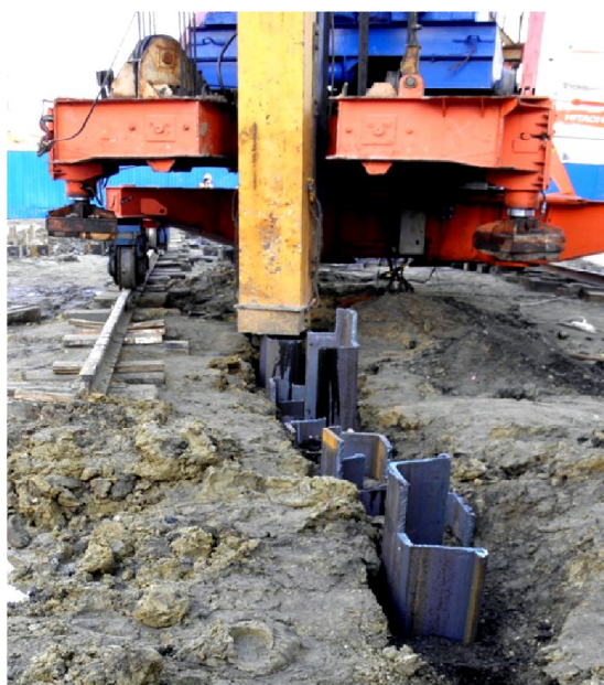
Рис.2 Ограждение из тяжелого шпунтового профиля типа Ларсен, погруженное методом вдавливания на строительстве подземного перехода
