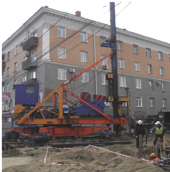
Рис. 3. Вдавливание шпунта типа Ларсен на начальном этапе строительстве подземного перехода в районе пр. Маркса
