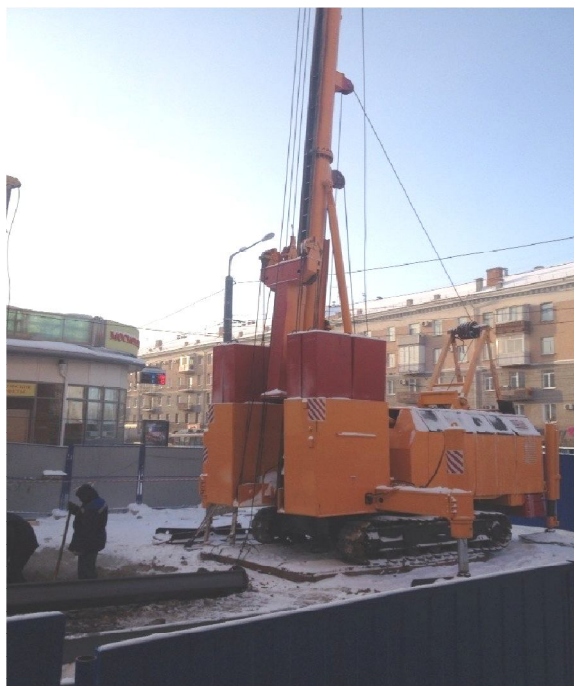
Рис. 4. Вдавливание шпунта установкой СВУ-В-6 на строительстве подземного перехода в г. Омске
