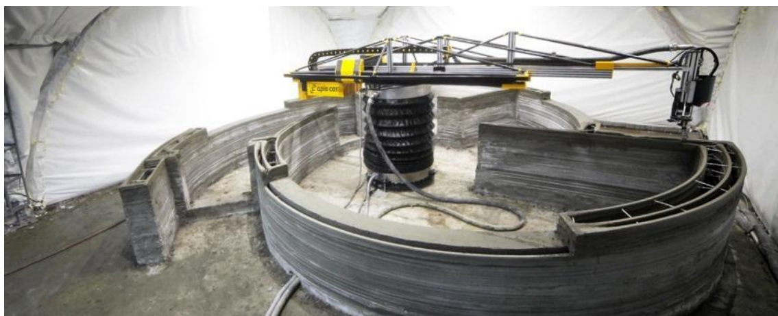
Рисунок 2 – Робот для 3D-печати зданий ApisCor
