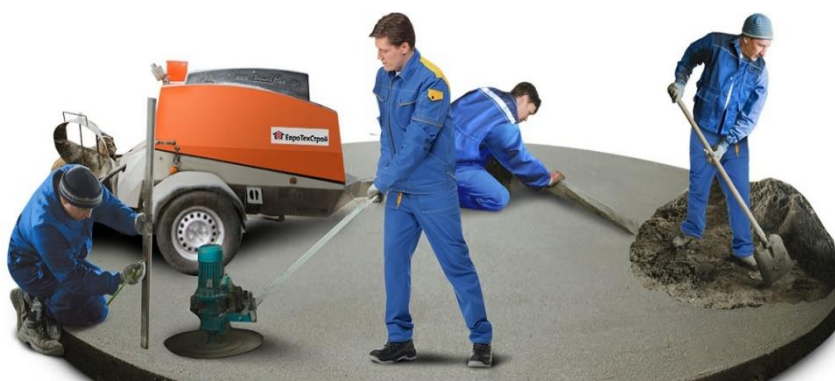
Рисунок 1 – Механизация работ по устройству стяжки пола
