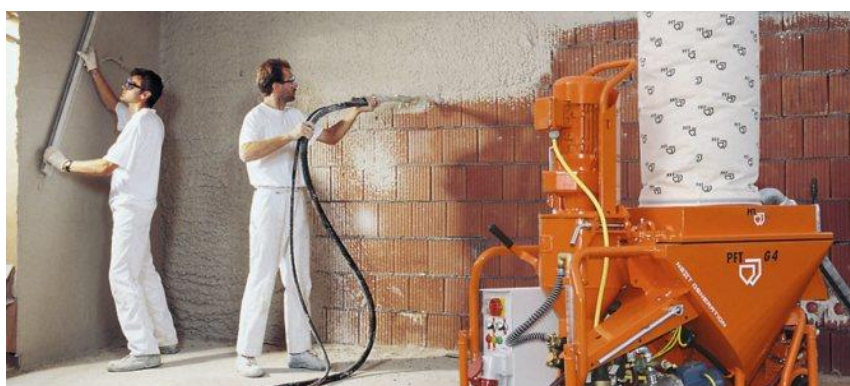
Рисунок 2 – Механизация штукатурных работ
