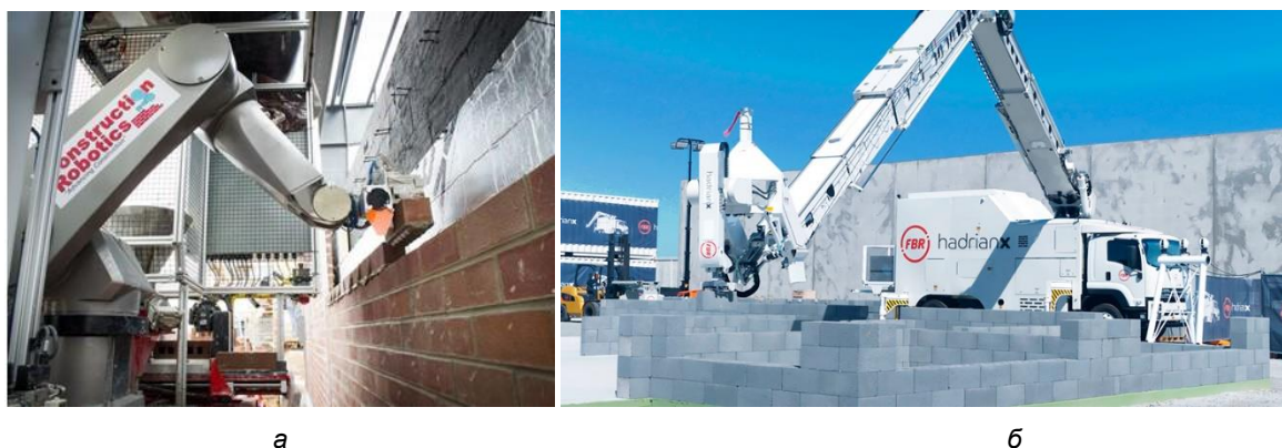
Рисунок 1 – Роботы-каменщики: а – робот-каменщик SAM100; б – робот-строитель HadrianX
