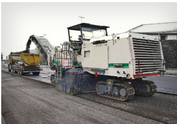
Рис. 4. Снятие слоя покрытия фрезой
