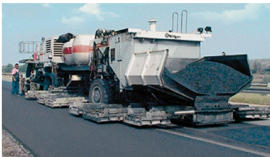
Рис. 5. Устройство покрытия с использованием мобильного агрегата Remixer
