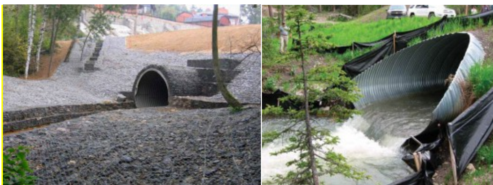
Рис. 4. Выходные участки водопропускных труб круглого и арочного сечения
