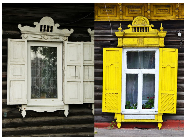
Рис. 3. Оформление оконных проемов наличниками с диадемой в виде полусолнца. Слева направо: ул. Тарская, 42; ул. Тарская, 38
