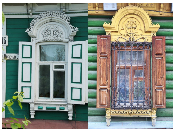
Рис. 2. Оформление оконных проемов резными деревянными наличниками с лобовой доской-полусолнцем. Слева направо: ул. Красных Зорь, 16; ул. Красных Зорь, 43
