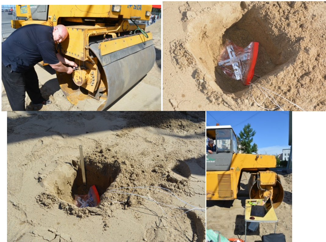
Рисунок 11– Исследования уплотнения супесчаных грунтов катком Stavostroj STA VHS 102K
