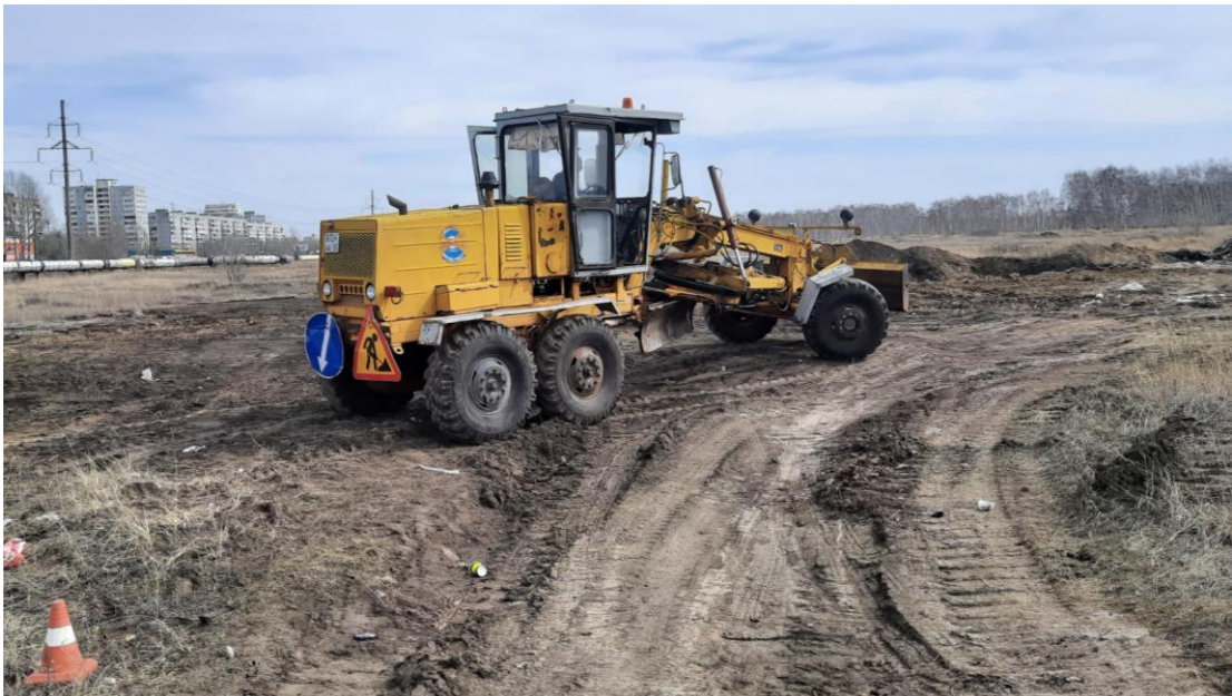
Рисунок 6.1.1 – Автогрейдер ГС-14.02 на полигоне
