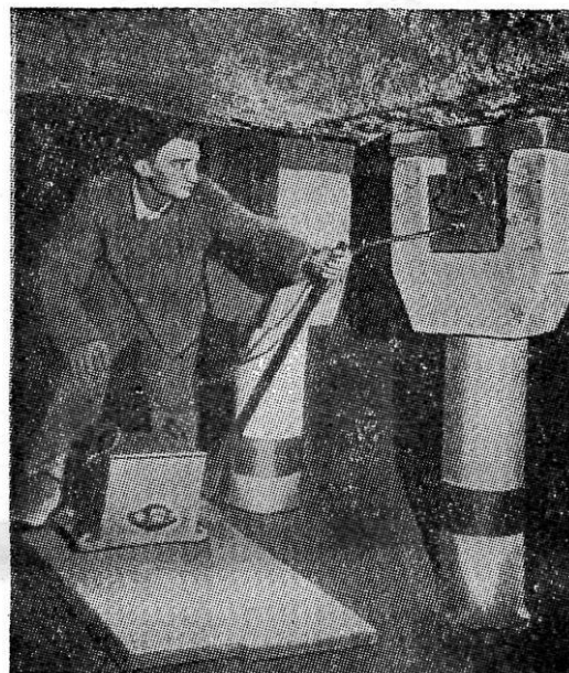
Рис. 4. Процесс включения сваи в работу с помощью V-образного оголовка
