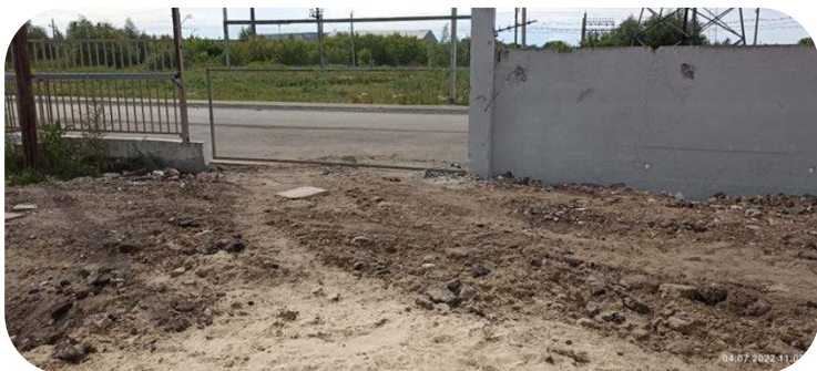
Работы по отсыпке, Завертяева,1
