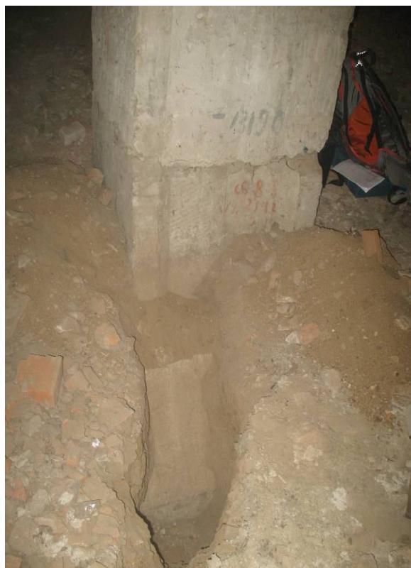
Рис. 2 . Шурф 3 в осях Б/12-13
